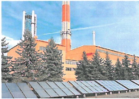
Nowa instalacja tarnowskiego MPEC składa się ze 100 kolektorów słonecznych
